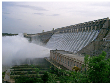
Nagarjuna Sagar Dam నాగారజునసాగరత్రనకటట్
